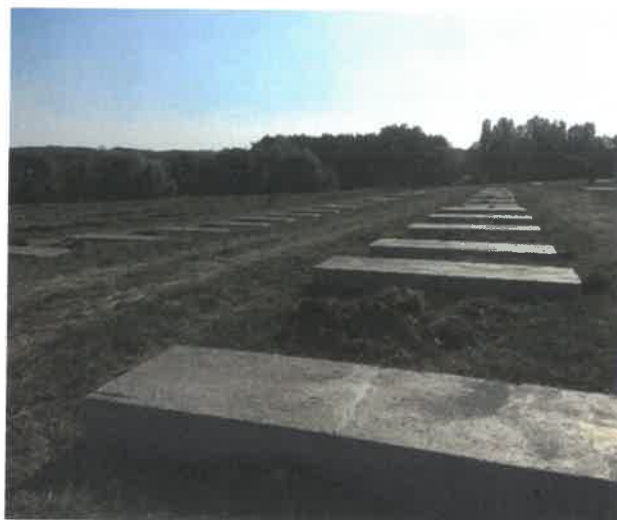
Exemple de mise en place de longrine - (Source : ENGIE PV PARGNY LES REIMS)
